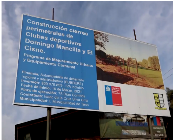
IMAGEN 22 LETRERO DE LA OBRA “CONSTRUCCIÓN CIERRES PERIMETRALES DE CLUBES DEPORTIVOS DOMINGO MANCILLA Y EL CISNE”
