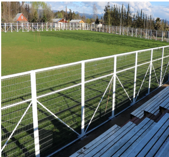
IMAGEN 16 CIERRE PERIMETRAL SANTA SUSANA
