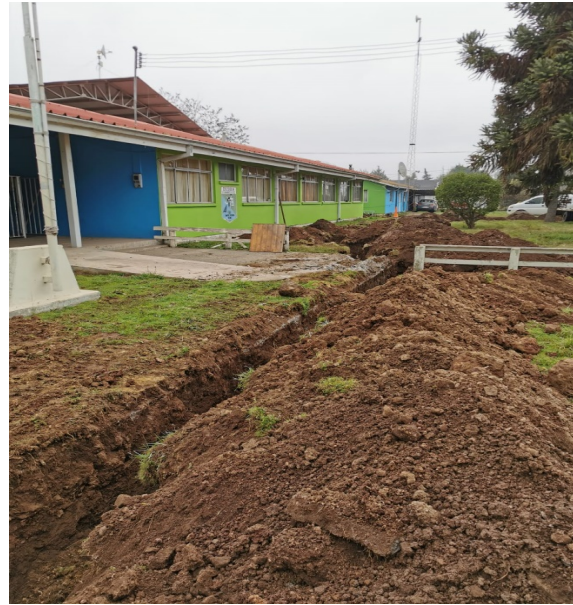
IMAGEN 32 OBRA ESCUELA SANTA SUSANA
